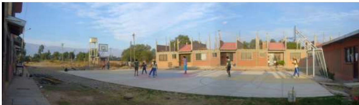
Figura 11. Cooperativa COVIVIR, espacio comunitario y viviendas. Cochabamba, Bolivia. Fuente: la autora, 2016.
